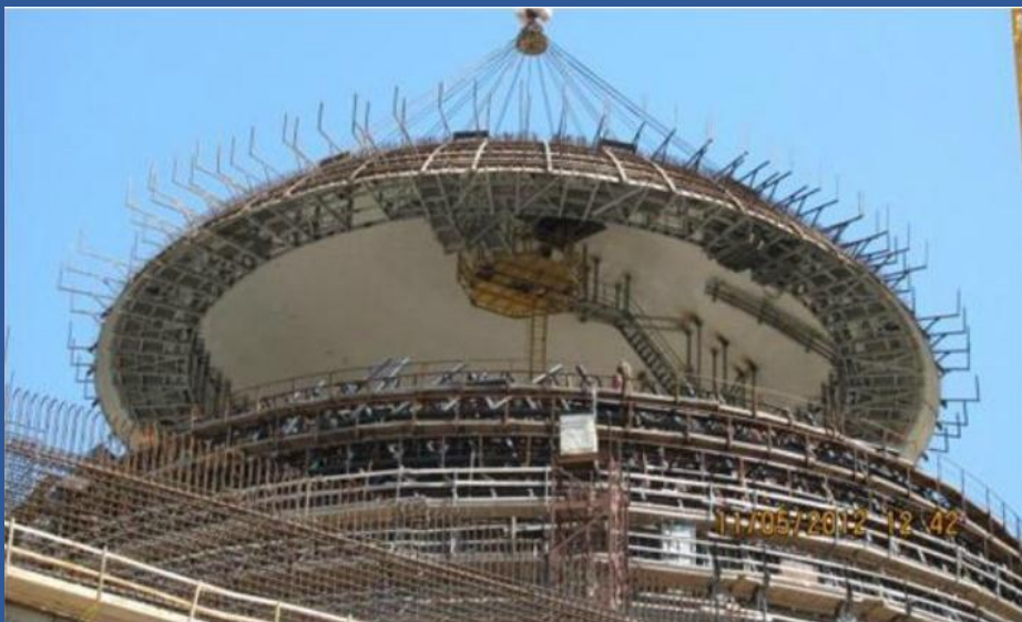
НВАЭС. Монтаж блока купола
