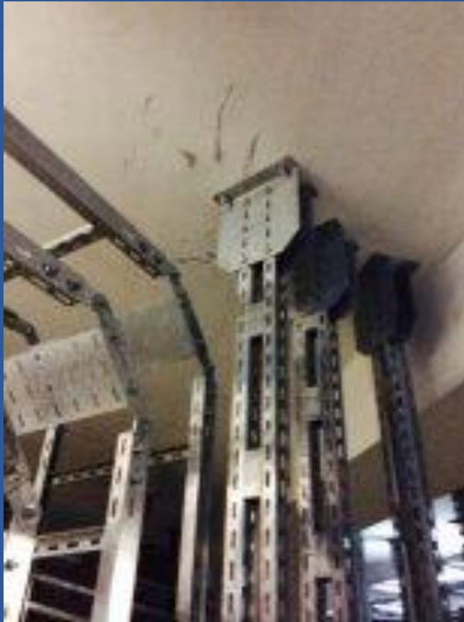
Крепление кабельных металлоконструкций в потолок анкерами
