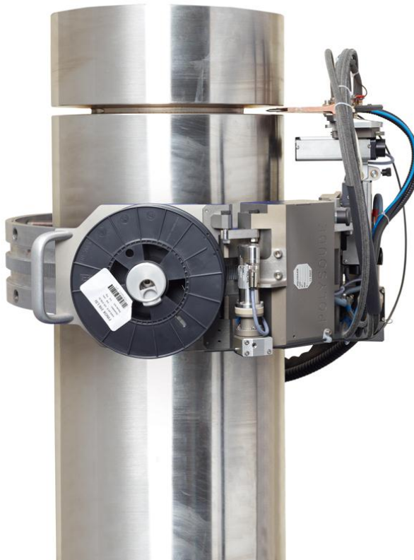
Сварка трубы Ду 350x40 мм из нержавеющей стали в узкую разделку (аналог трубопровода КД и САОЗ)
