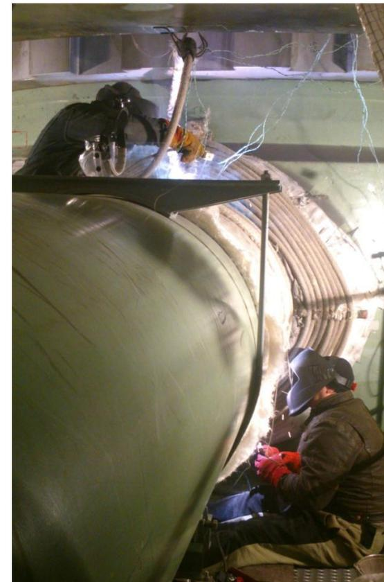
Заполнение сварного соединения двумя сварщиками на подъем
