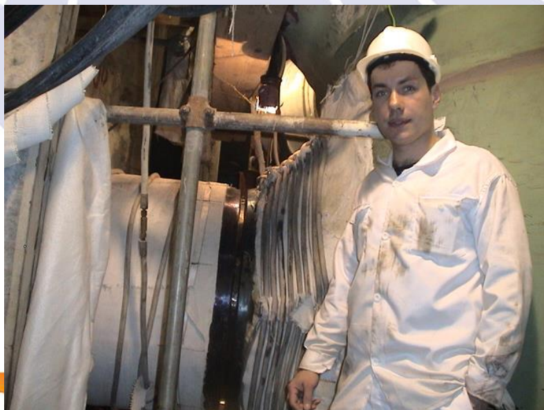
Подогрев под сварку и ТО
