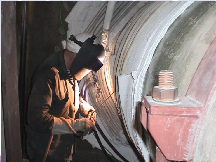
Сварка корня шва
