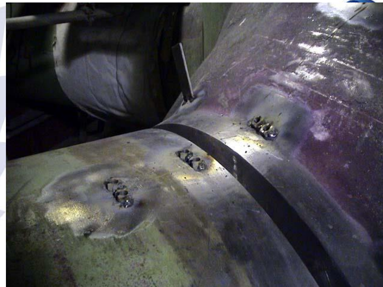
Удаление временных креплений
