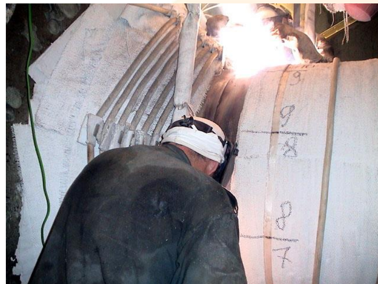
Сварка с подогревом
