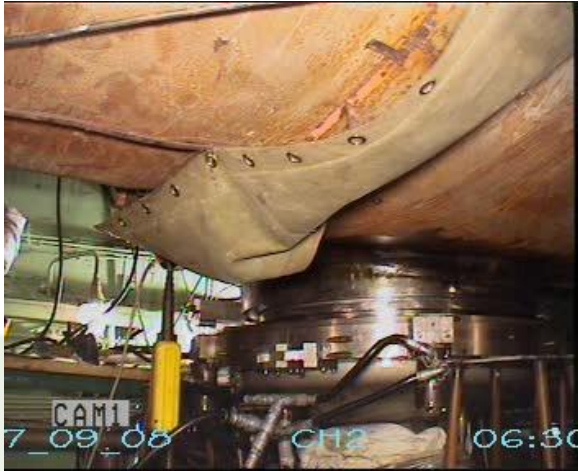
Установка трубореза
