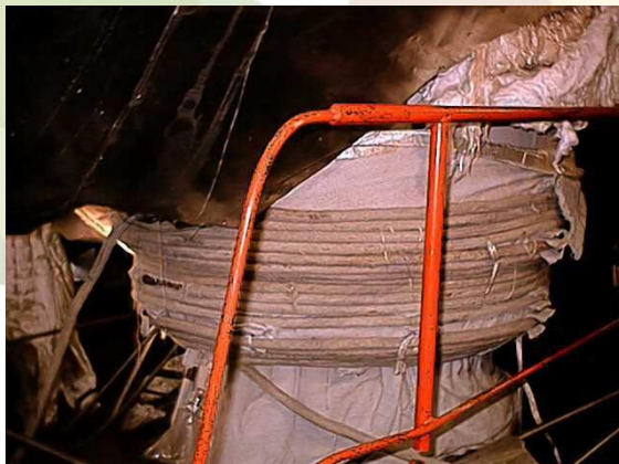
Узел крепления с индуктором для подогрева и термообработки
