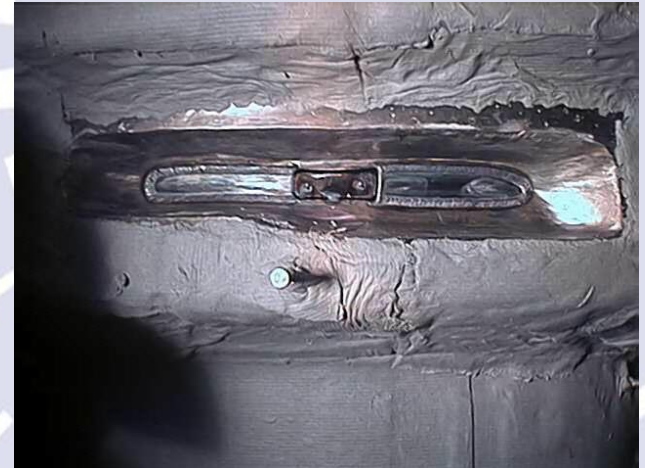
Начало ремонтной сварки
