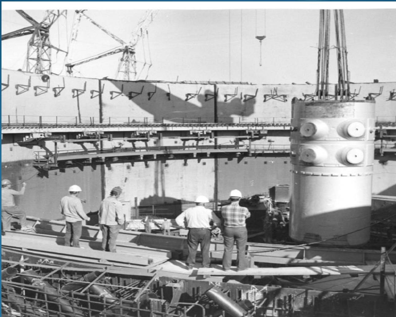
*Опускание корпуса реактора в шахту*
