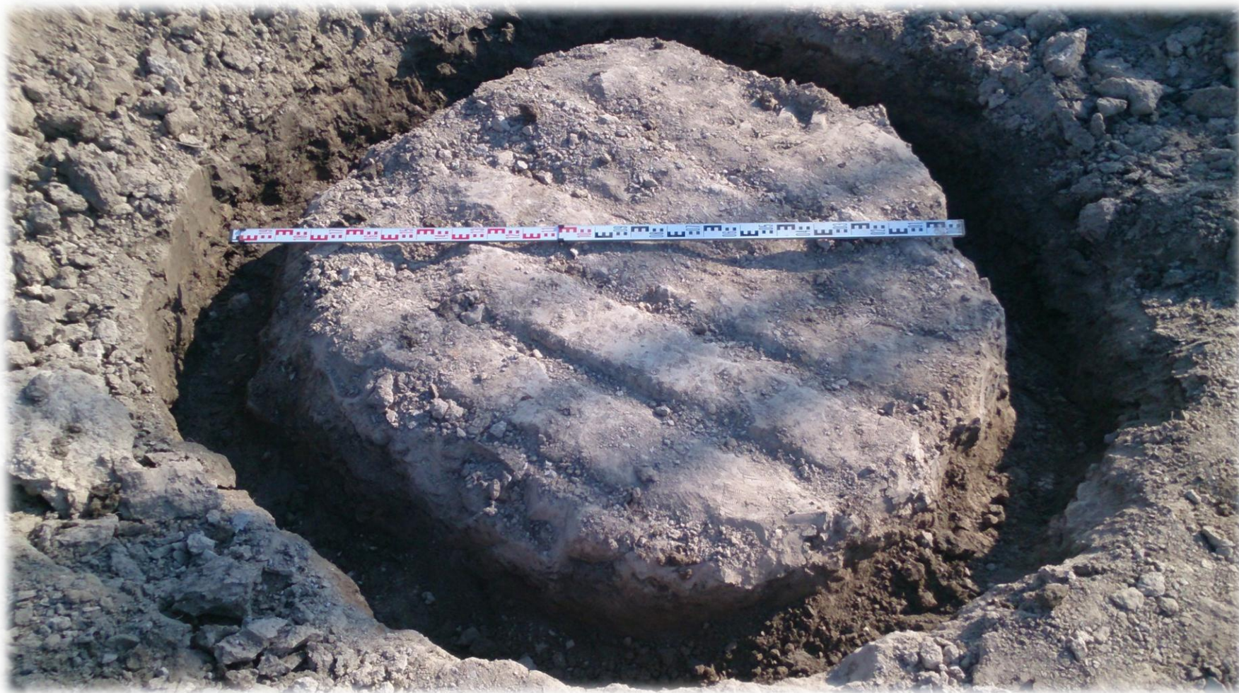
Грунтоцементная колонна \varnothing 1800 мм
