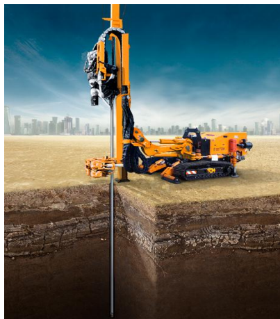
2. Бурение пилотной скважины до проектной отметки
