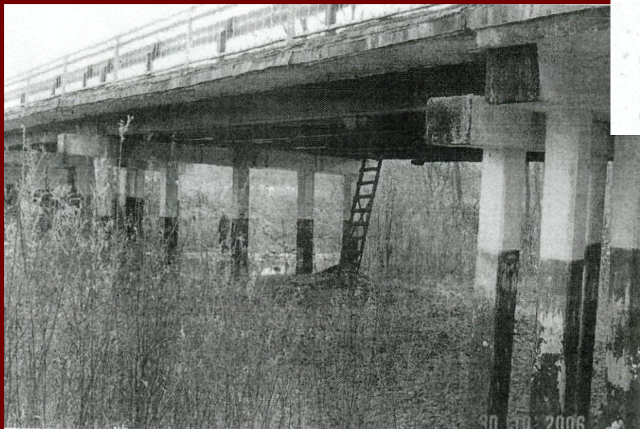
Мост в Приморском крае возведен в 1984г.
